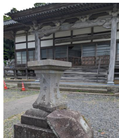
浄明寺本堂と倒壊した常夜灯
