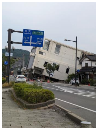
輪島市内の倒壊したビル
