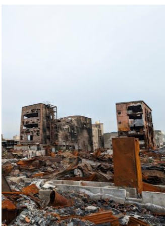
朝市の火災現場
