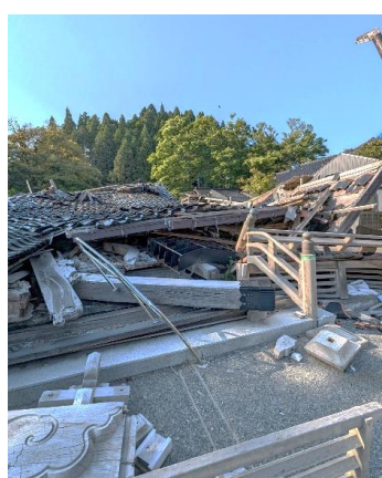
全壊した西勝寺本堂
